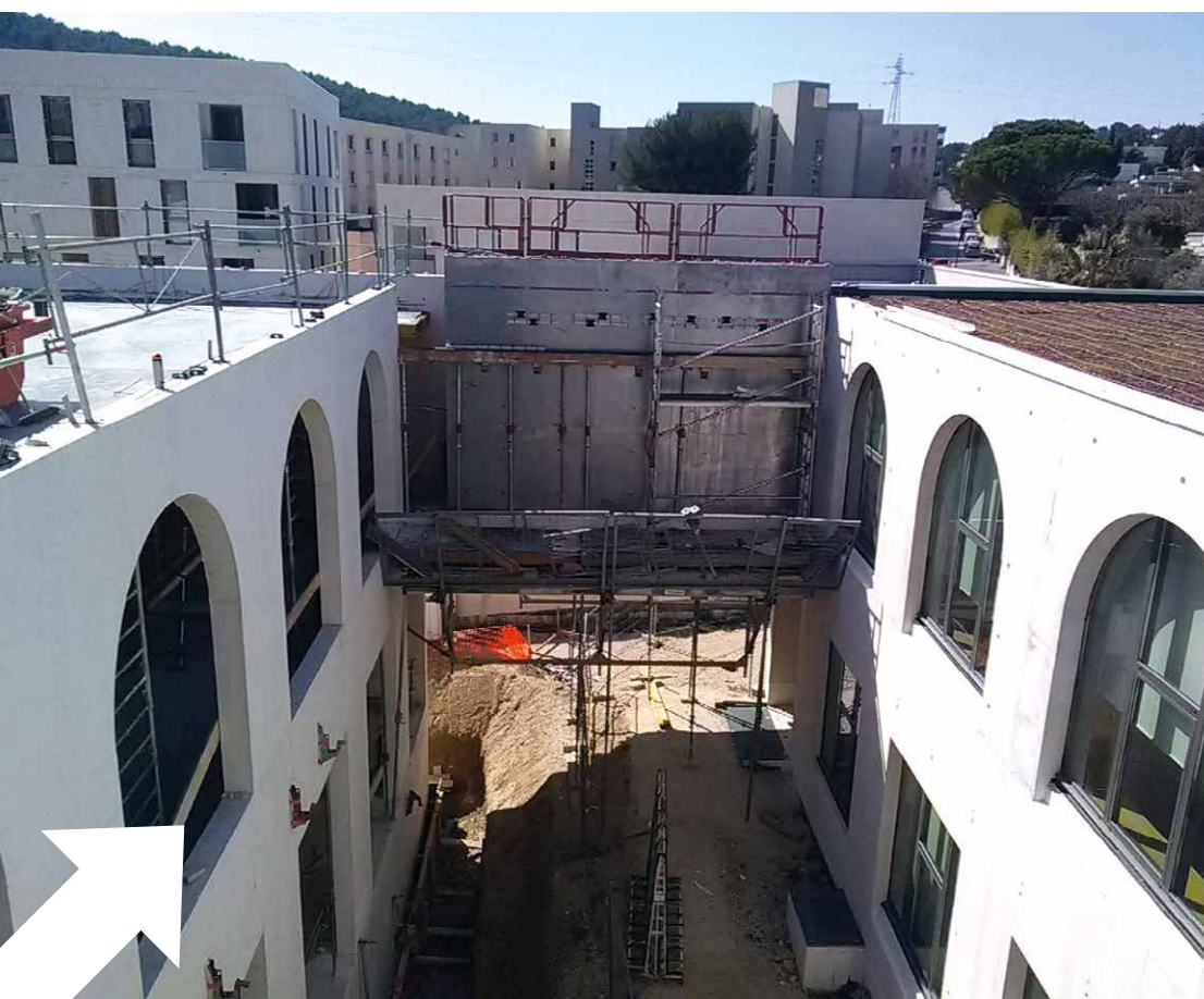
Programmation de la fin des travaux de l'Hôtel de ville en début d'été, suivie de l'aménagement des abords.
